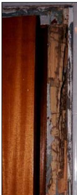
**Figura 1.** Daños producidos por las termitas en un marco de puerta. Sus destrozos se manifiestan por la acción prolongada de las termitas.
